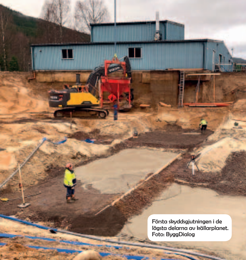
Schaktet söder om det befintliga reningsverket, grundvattnet syns tränga fram. Foto: Hilary Högfeldt.
