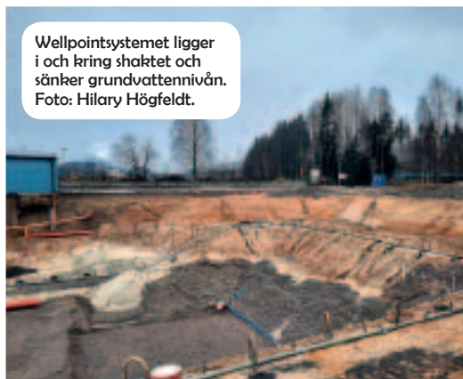
Det djupaste schaktet där inloppspumpstationen kommer att byggas. Foto: Hilary Högfeldt.
